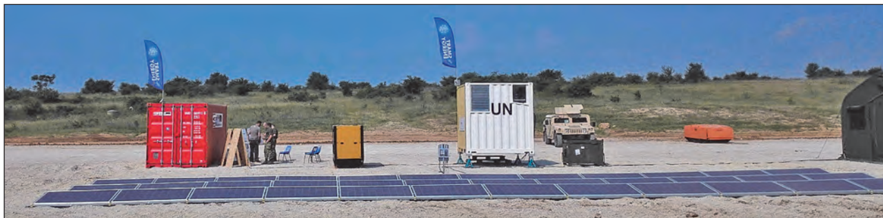
10. ábra. A holland ESTechnologies megoldása. A piros konténerben érkeztek a napelemek, a sárga egység az aggregátor, a fehér konténerben található a vezérlés és az akkumulátorok
