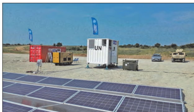
11. ábra. Az ESTechnologies berendezése a zöld konverteren keresztül, két héten át látott el egy klimatizált sátoztábornak villamos energiával
