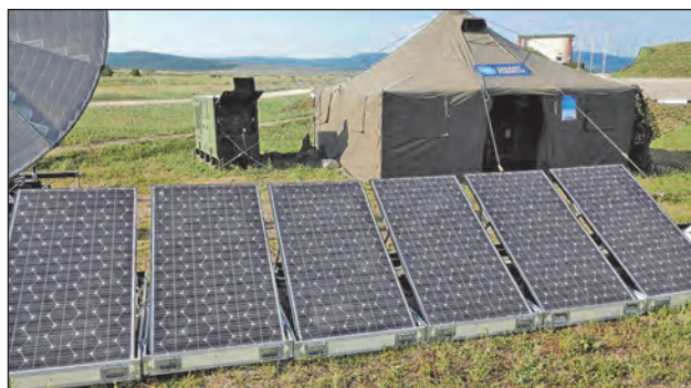
15. ábra. A sátor melletti khaki színű fémdoboz rejti a görög IDE Intracom hibrid rendszerét. A kompakt egység tartalmazza a dízelaggregátort is
